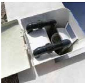
**Tuberías con salida trasera vertical**
